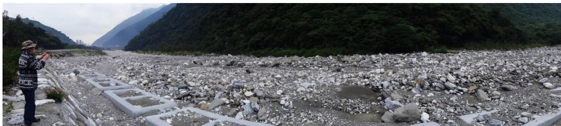
照 4-1-3-4 澳花溪二支流處與主流交匯處堤防之澳花溪全景。
