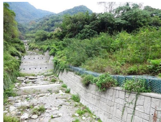
照 4-1-2-1 楓溪一支流防災工程。
