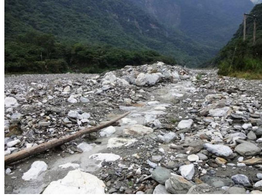
照 4-1-4-1 高壟河河床堆積物已高於堤防。
