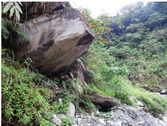
照 4-1-7-2 楓溪與澳花溪交會口兩側有巨礫堆積，形成不穩定河階，下切後巨礫突出。
