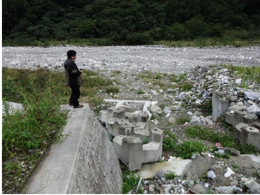
照 4-1-2-2 消波塊、水平格樑保護堤防。
