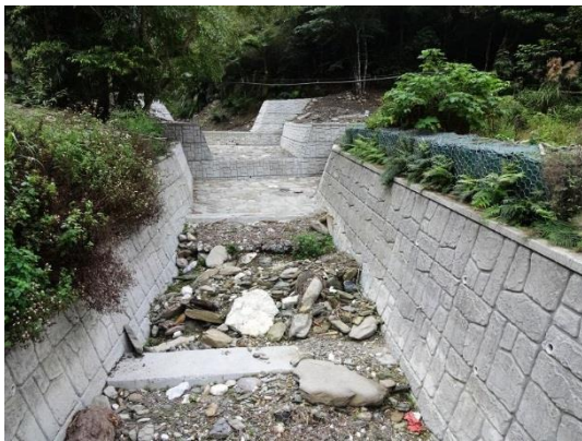
照 4-1-8-1 高位河階野溪整治—防災工程主體是層層攔截的梳子壩。
