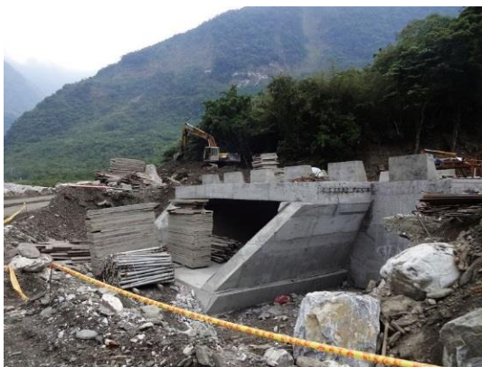
照 4-1-3-1 施工中的楓溪二號支流防災工程。
