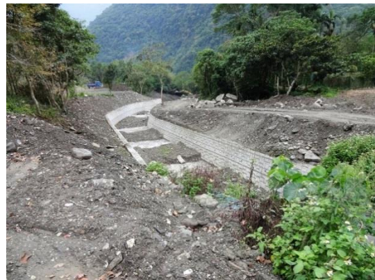
照 4-1-8-2 由澳花溪中游下望，野溪整治梳子壩幾乎被填滿將失去效用。
