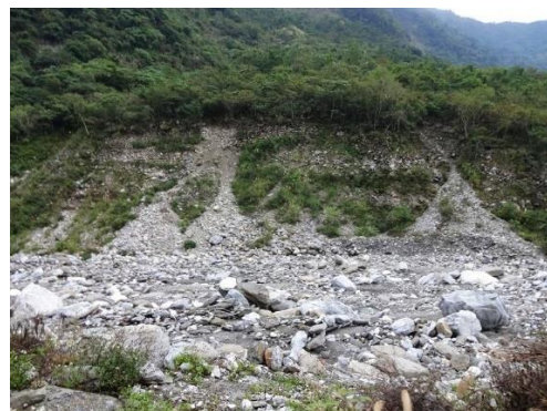
連續的邊坡崩落
