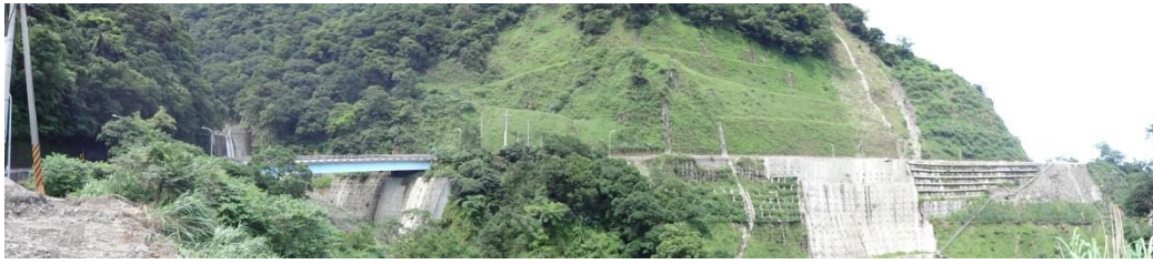
照 4-1-1-3 大坑橋防災工程
