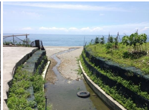
照 4-3-3-2 沒口溪與護堤工程
