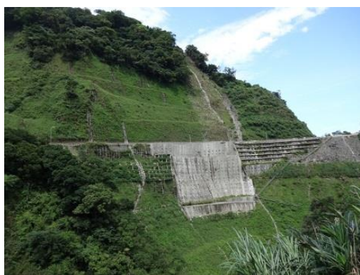
照 4-1-1-1 大坑橋防災工程
