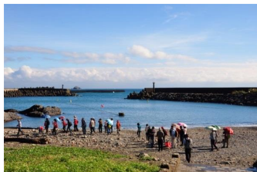
照 4-2-1-2 開口方向設計有瑕疵的港口
