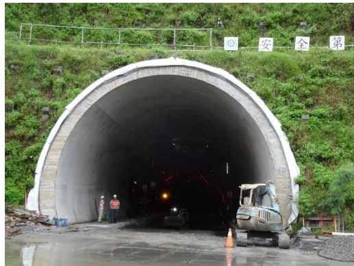
圖版 4、武塔隧道南口左側車道。
