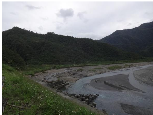
圖版 10、無名溪曲流基蝕坡及護坡。
