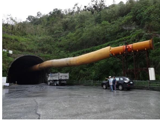
圖版 6、觀音隧道北口通風排氣管。
